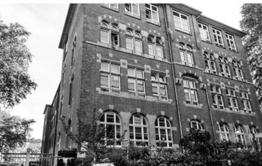
Das ehemalige Schulgebäude in der Dagobertstraße
